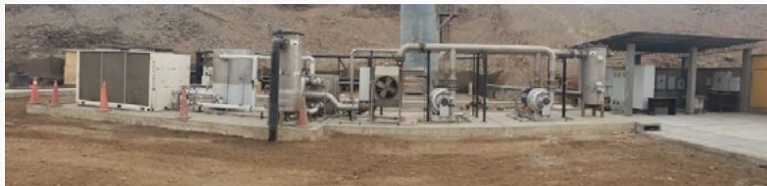
INSTALACIÓN DE SISTEMA BIOGAS PLANTA HUAYCOLORO PETRAMAS
