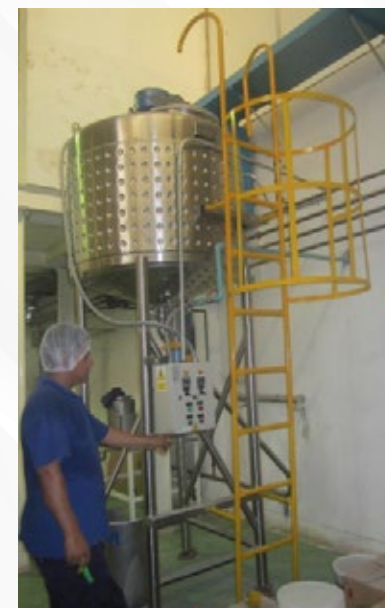
FABRICACION E INSTALACION DE TANQUE CON ESCALERA DE ACCESO. MOLITALIA
