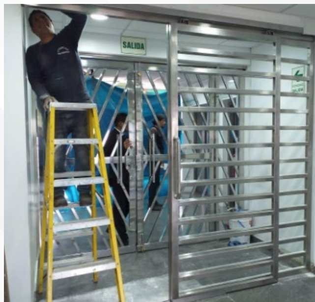
FABRICACION E INSTALACIÓN DE REJAS EN ACERO INOX. PETRAMAS- OF. ADMINISTRATIVAS
